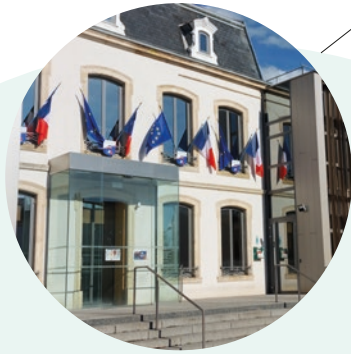
Réfection et aménagement de l'Hôtel de Ville 273 000 € HT
